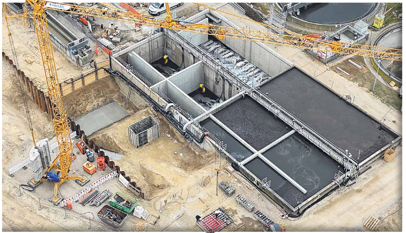
Der Blick von oben zeigt: Das rechte Belebungsbecken ist bereits fertig. Das linke zeigt die Inbetriebnahme der neuen Belüfterplatten.
