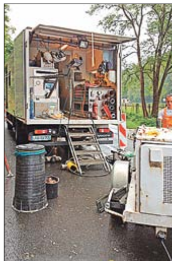
Für die unterirdische Sanierung ist viel Technik gefragt.
