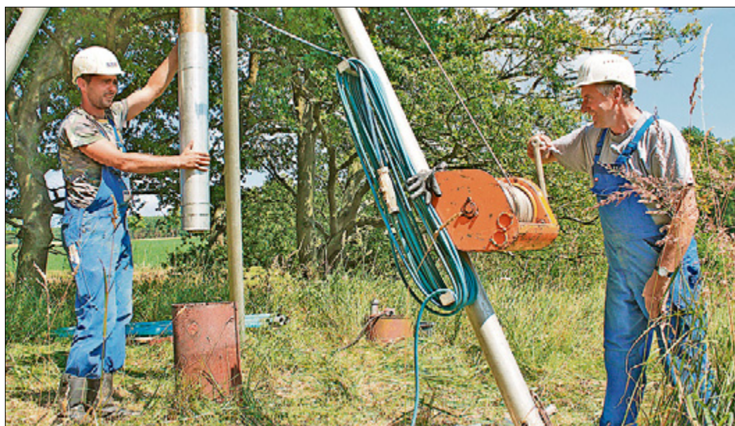
Die Brunnenbauer Sascha Janze (l.) und Günter Köpsel bringen die Pumpe in die richtige Position. Dann kann der Pumpversuch starten.
