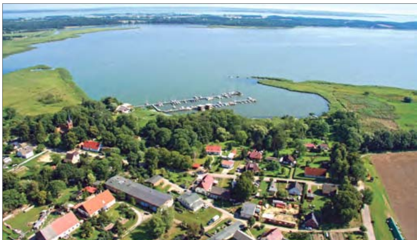
Gut durchdacht – die Ver- und Entsorgungskonzepte für die idyllisch am Haff liegende Gemeinde Krummin werden umgesetzt.
