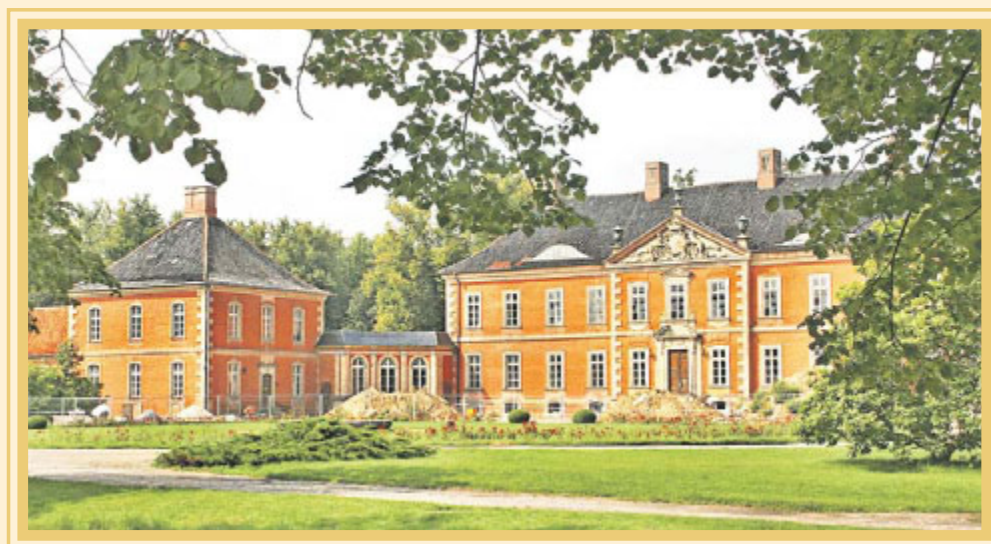
Gegenwärtig wird das Schloss Bothmer durch das Land aufwendig saniert. 2015 soll es alle Türen wieder öffnen.
