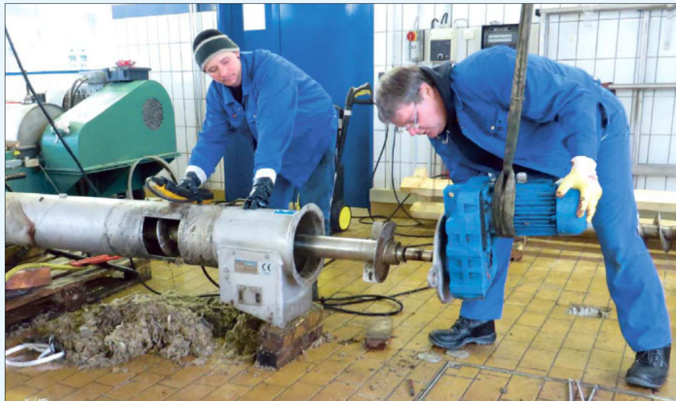
Arbeiten kraftvoll Hand in Hand. Meister Andreas Ring (re.) und Sven Thees warten die Siebrechenanlage auf der Kläranlage Zinnowitz.
